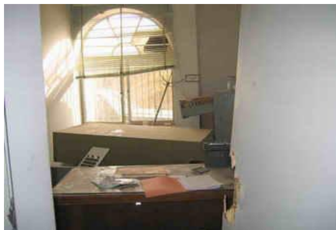
شکل ۱: نمونه واژگونی فایلها و باز شدن کشو کمد بایگانی در زلزله بم
